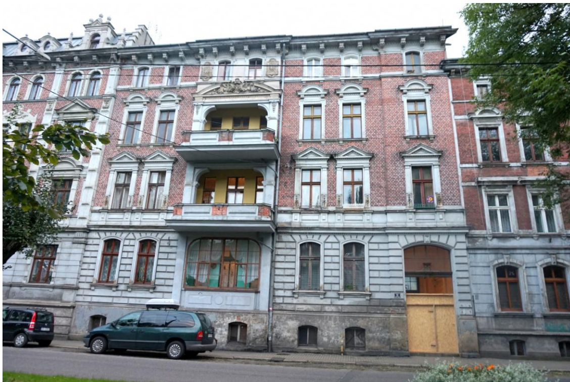
Widok budynku od północy
