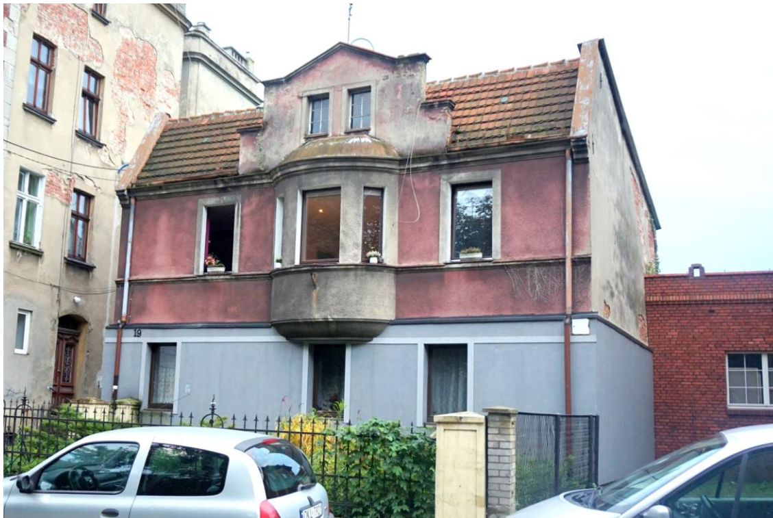
Widok budynku od północy
