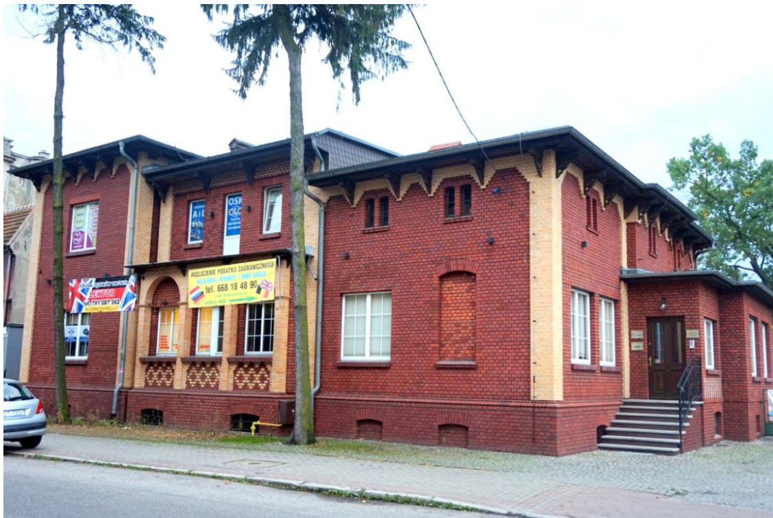
Widok budynku od północy
