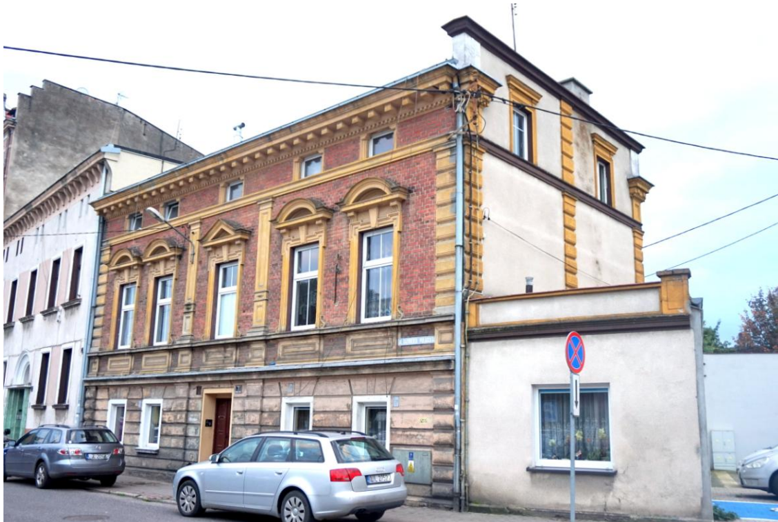
Widok budynku od północy
