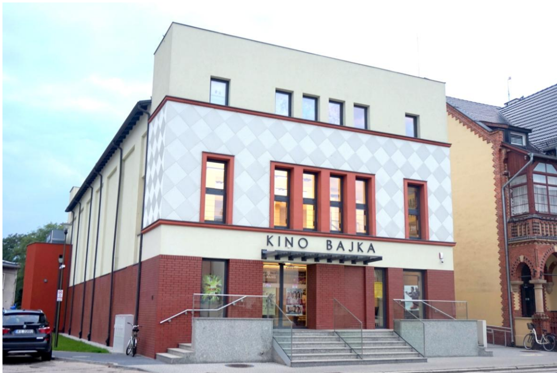
Widok budynku od wschodu
