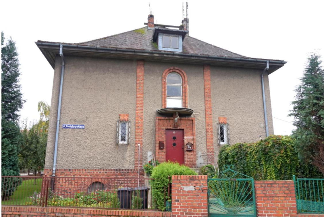
Widok budynku od północy
