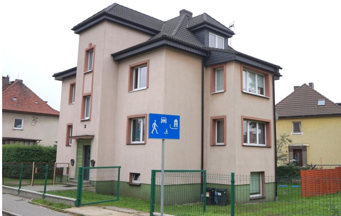
Widok budynku od północnego - zachodu
