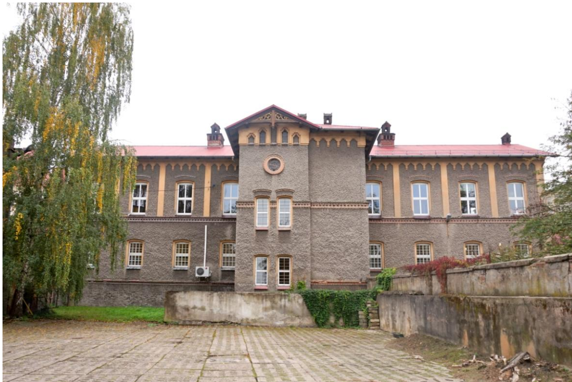
Widok budynku od północy
