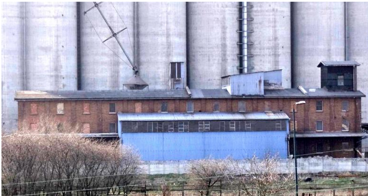
Widok budynku od wschodu
