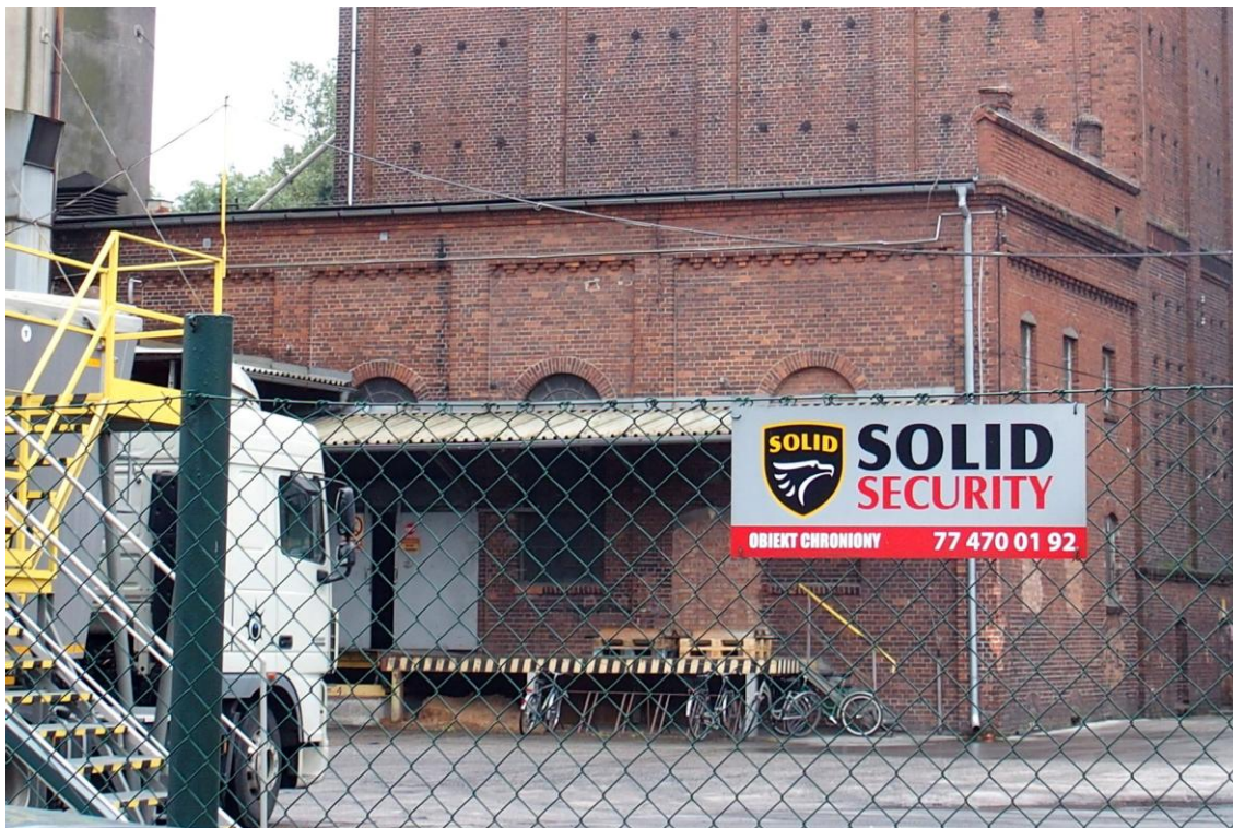
Widok budynku od północy
