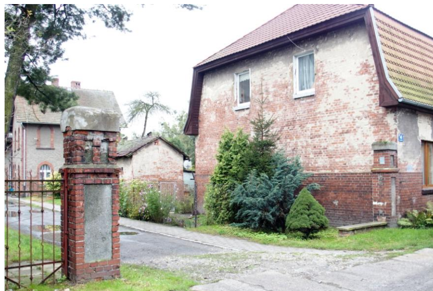
Widok budynku od północnego - wschodu
