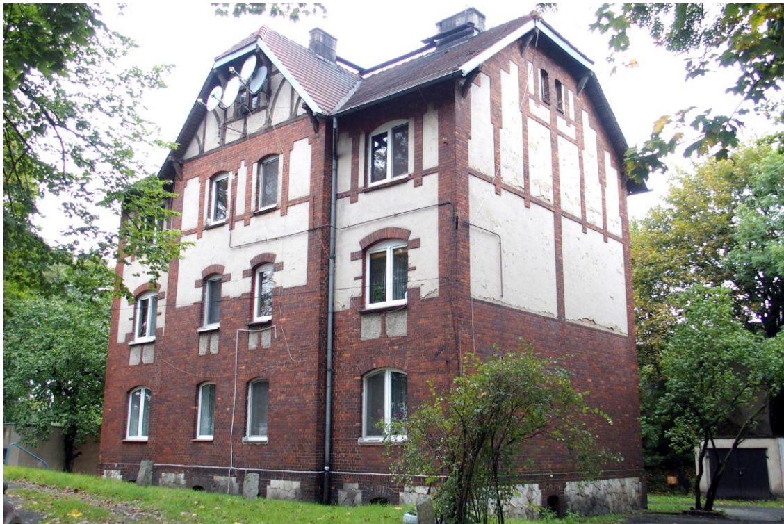
Widok budynku od południowego - wschodu
