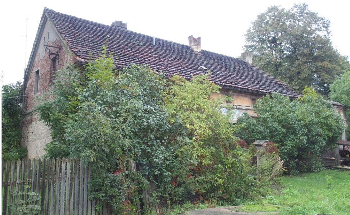
Widok budynku od południowego - zachodu
