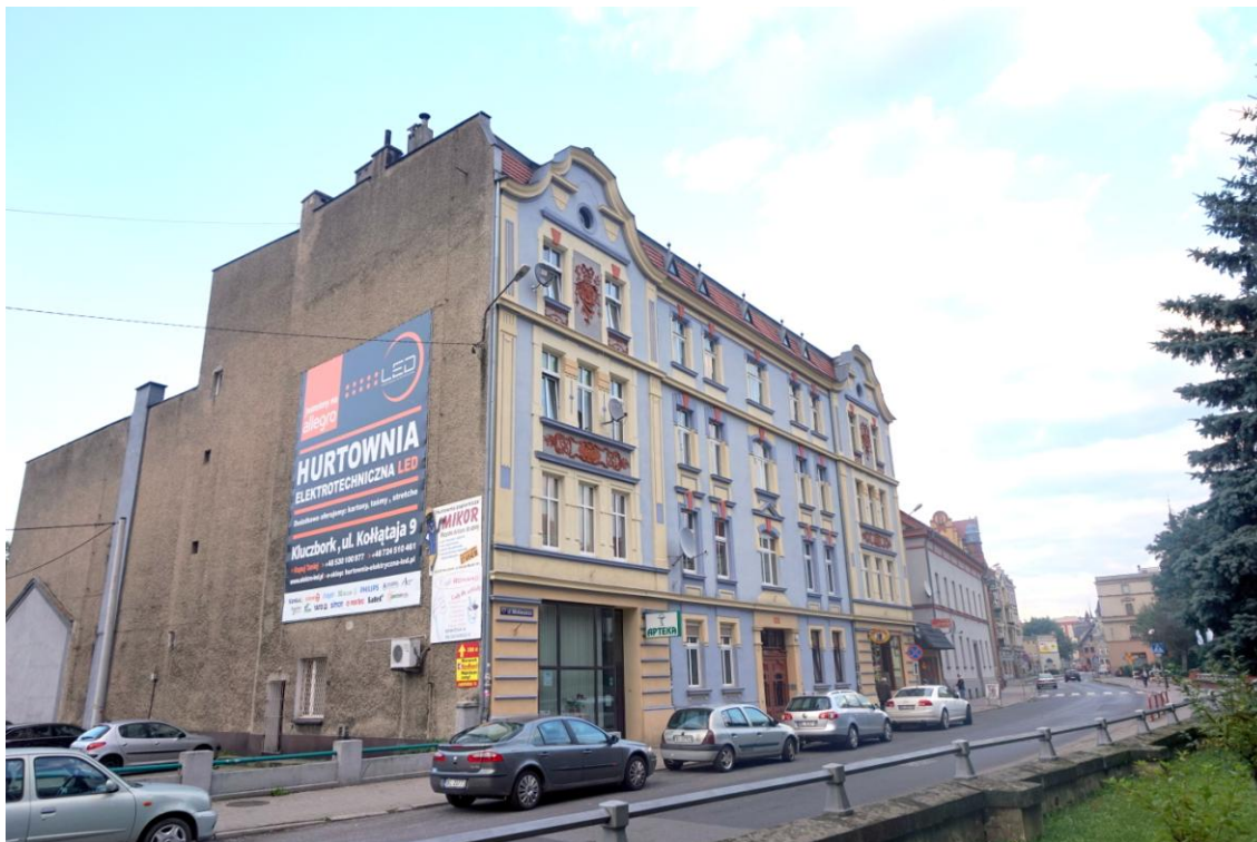
Widok budynku od południowego - zachodu
