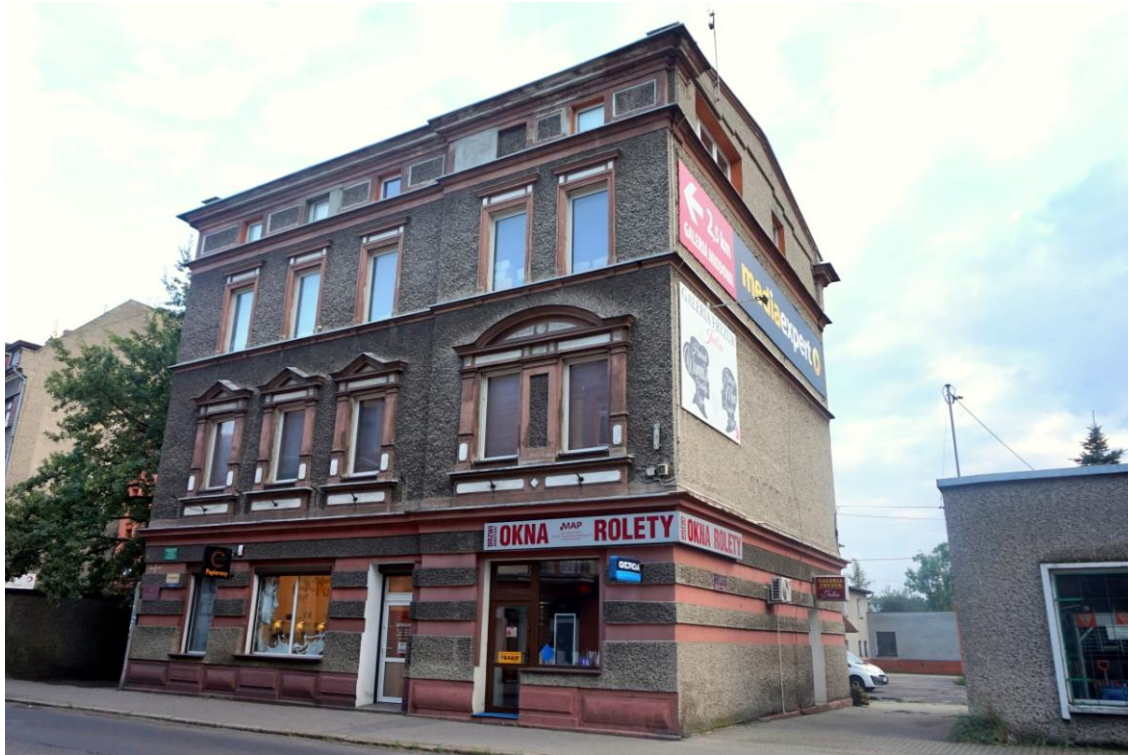
Widok budynku od północnego - zachodu
