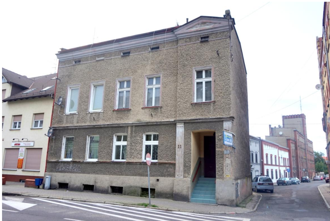
Widok budynku od południowego - wschodu
