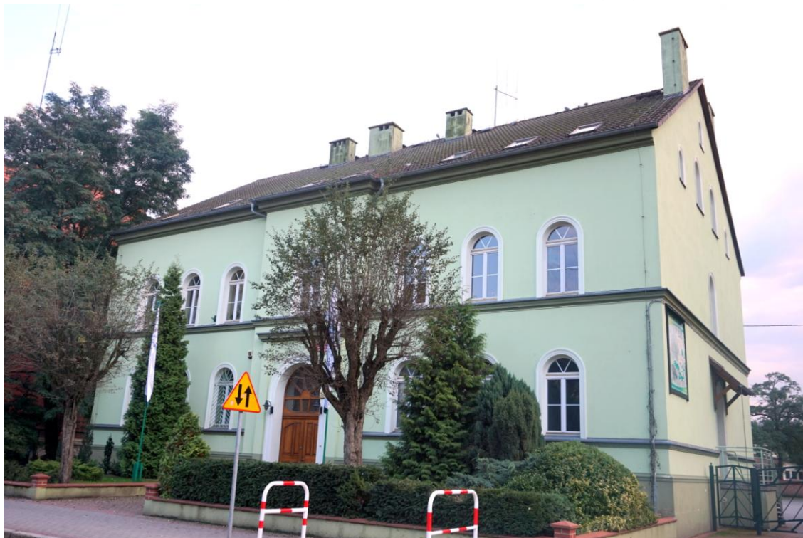
Widok budynku od północnego - zachodu
