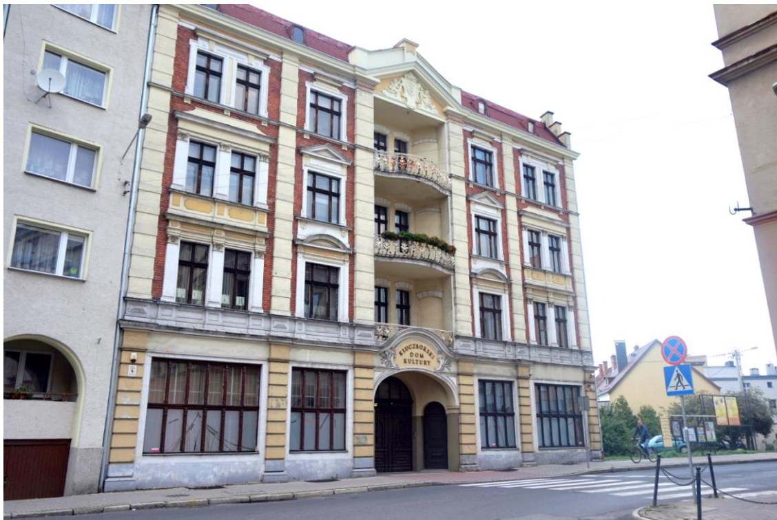
Widok budynku od południowego - zachodu
