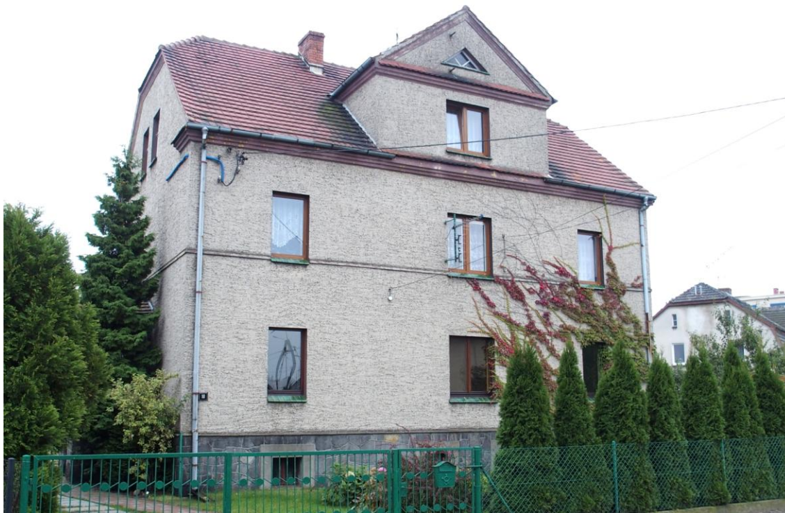
Widok budynku od północnego - zachodu
