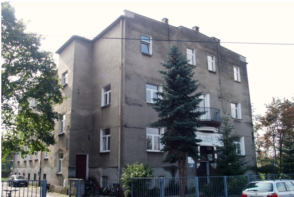
Widok budynku od północnego - wschodu
