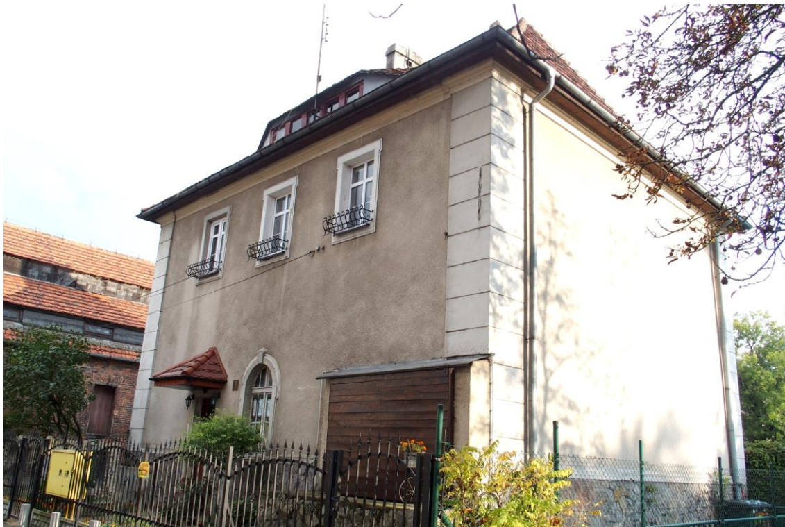
Widok budynku od północnego - wschodu
