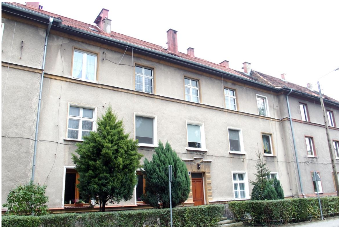
Widok budynku od północnego - zachodu
