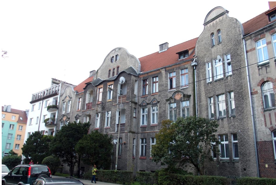
Widok budynku od północnego - wschodu
