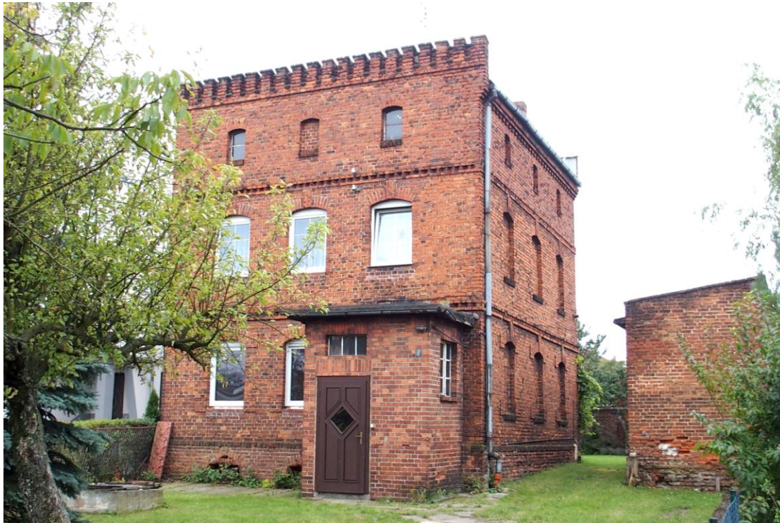
Widok budynku od północnego - zachodu
