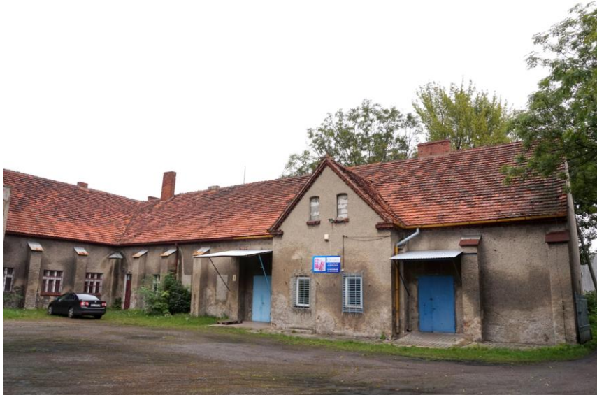
Widok budynku od południowego - zachodu
