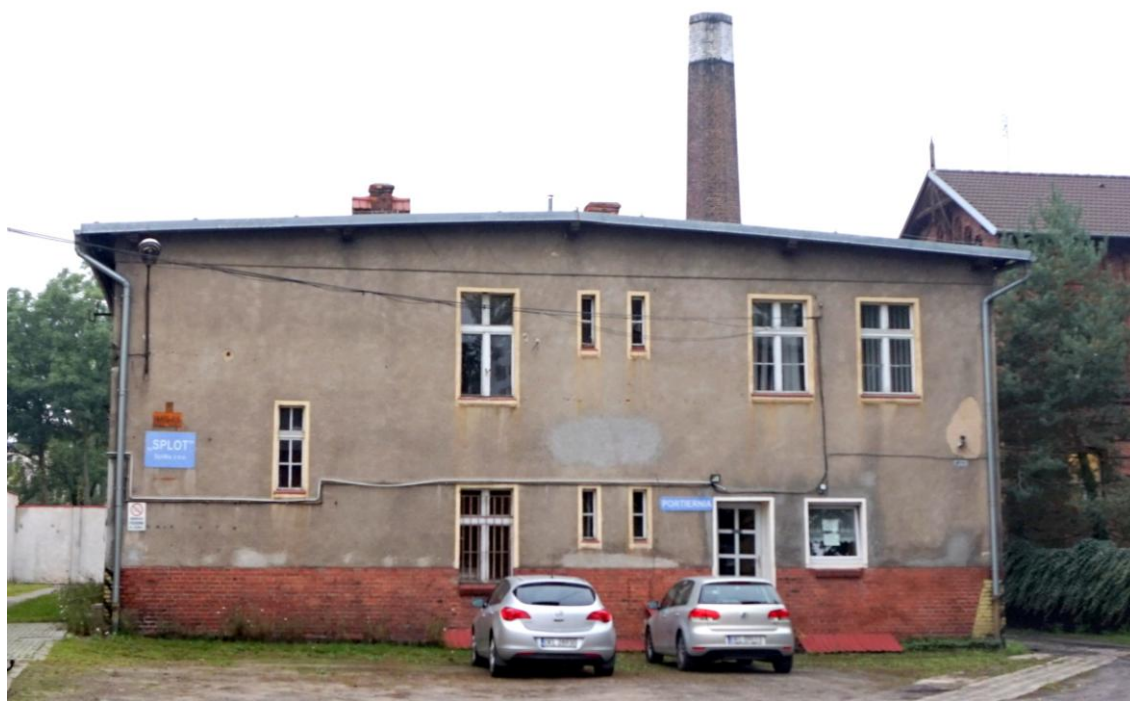
Widok budynku od wschodu
