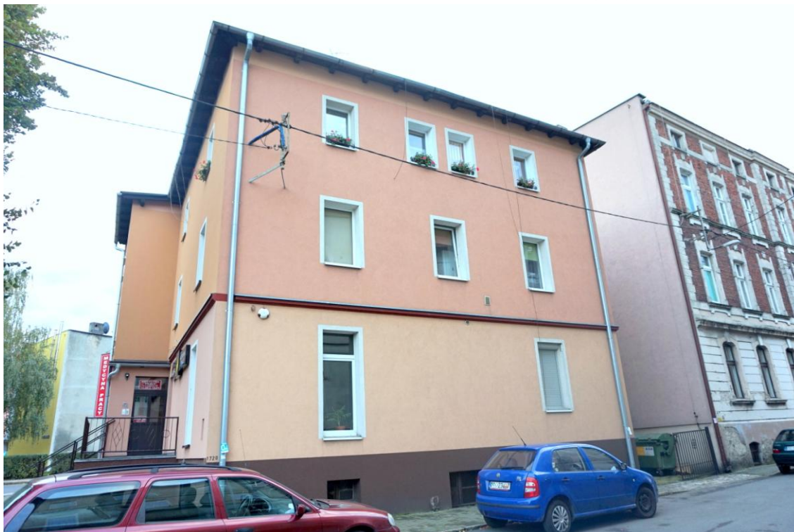
Widok budynku od północnego - zachodu
