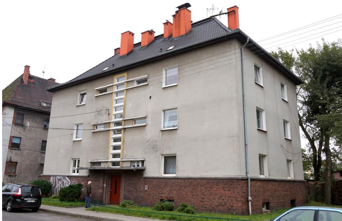
Widok budynku od północnego - zachodu
