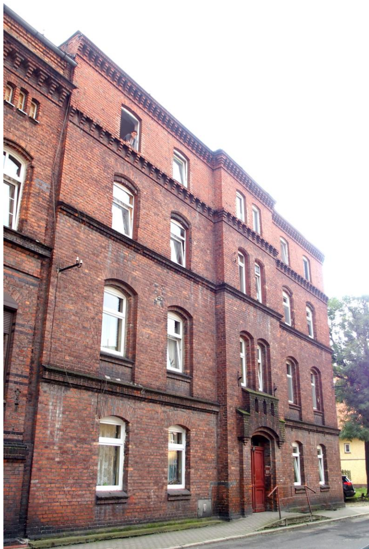
Widok budynku od północnego - wschodu
