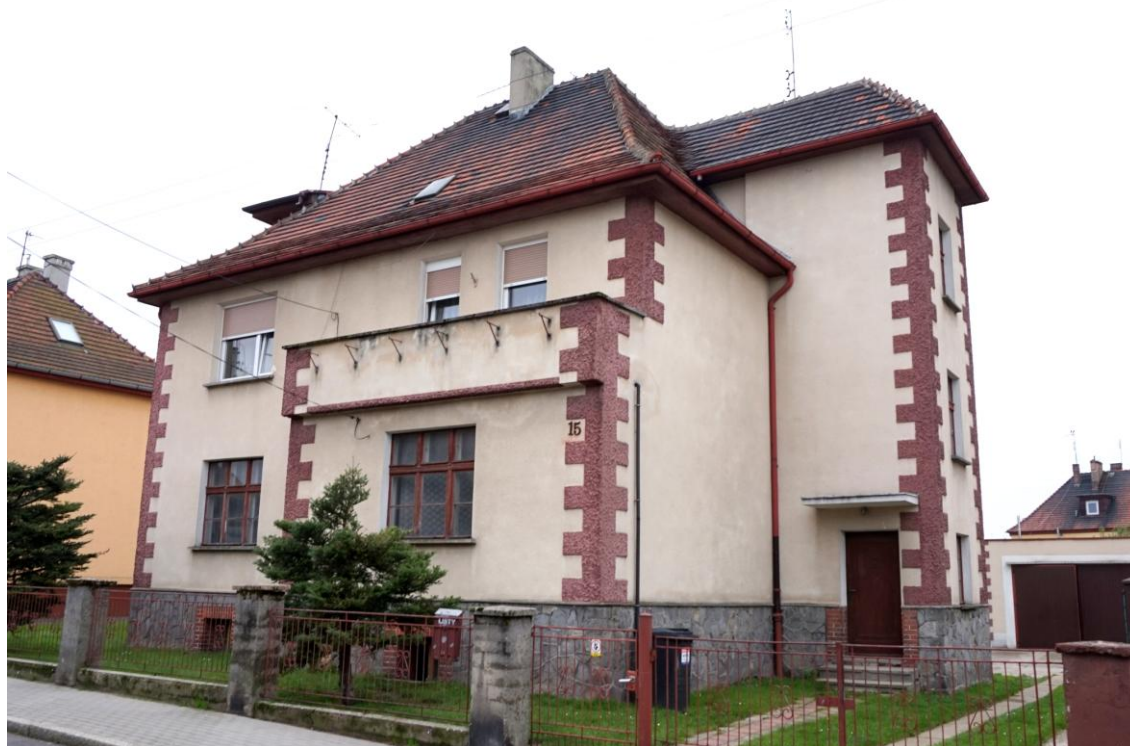
Widok budynku od północnego - wschodu
