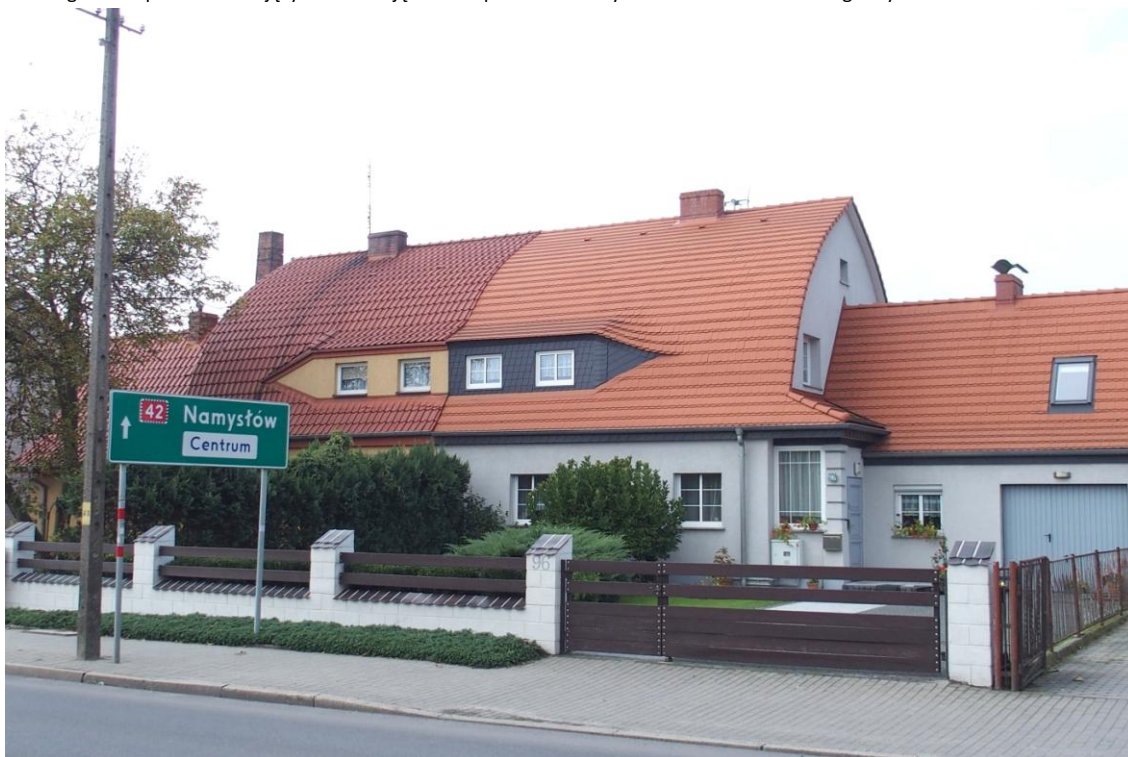
Widok budynku od wschodu
