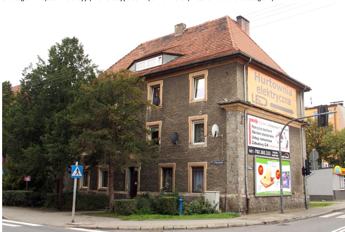
Widok budynku od północnego - wschodu
