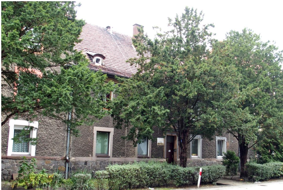
Widok budynku od wschodu
