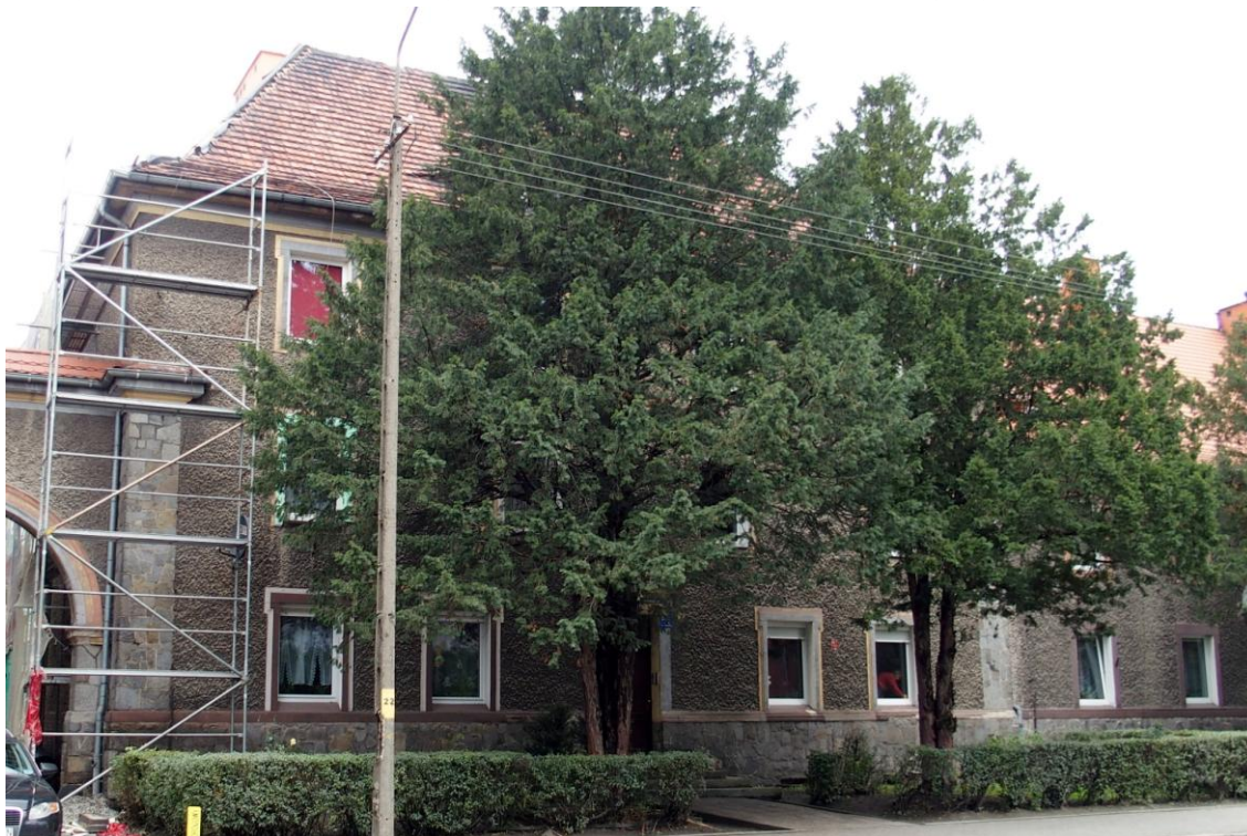
Widok budynku od wschodu
