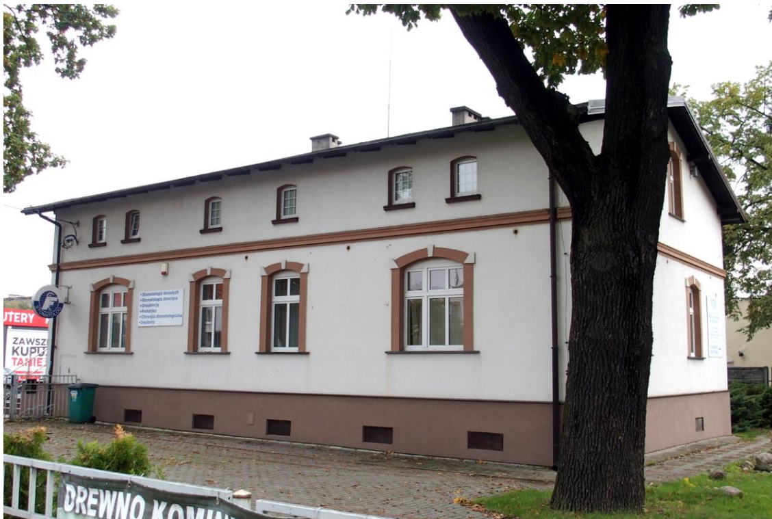
Widok budynku od południowego - zachodu
