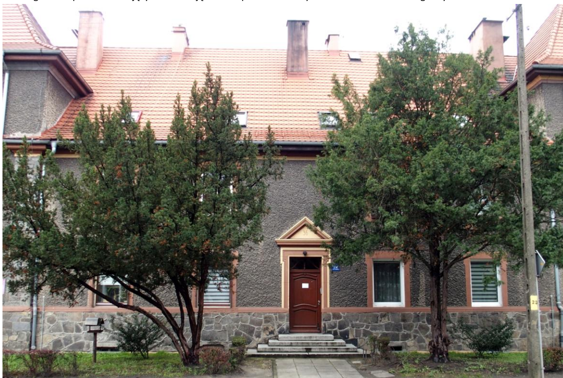
Widok budynku od
