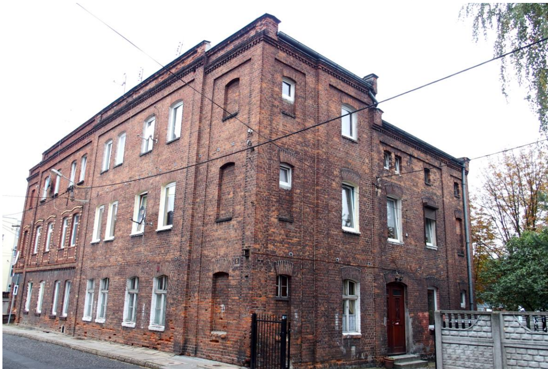
Widok budynku od południowego - wschodu
