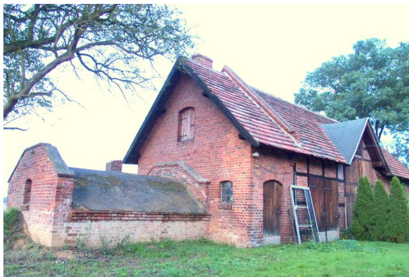
Widok budynku od południowego - zachodu
