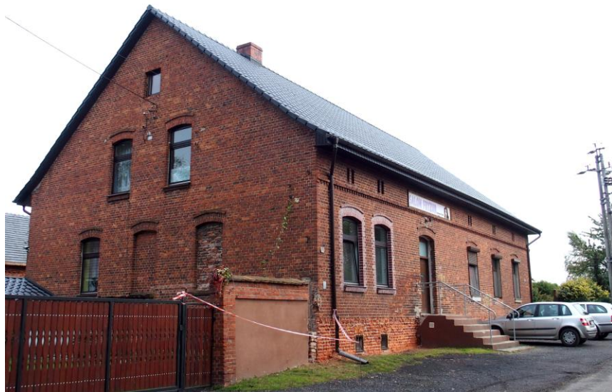
Widok budynku od północnego - zachodu
