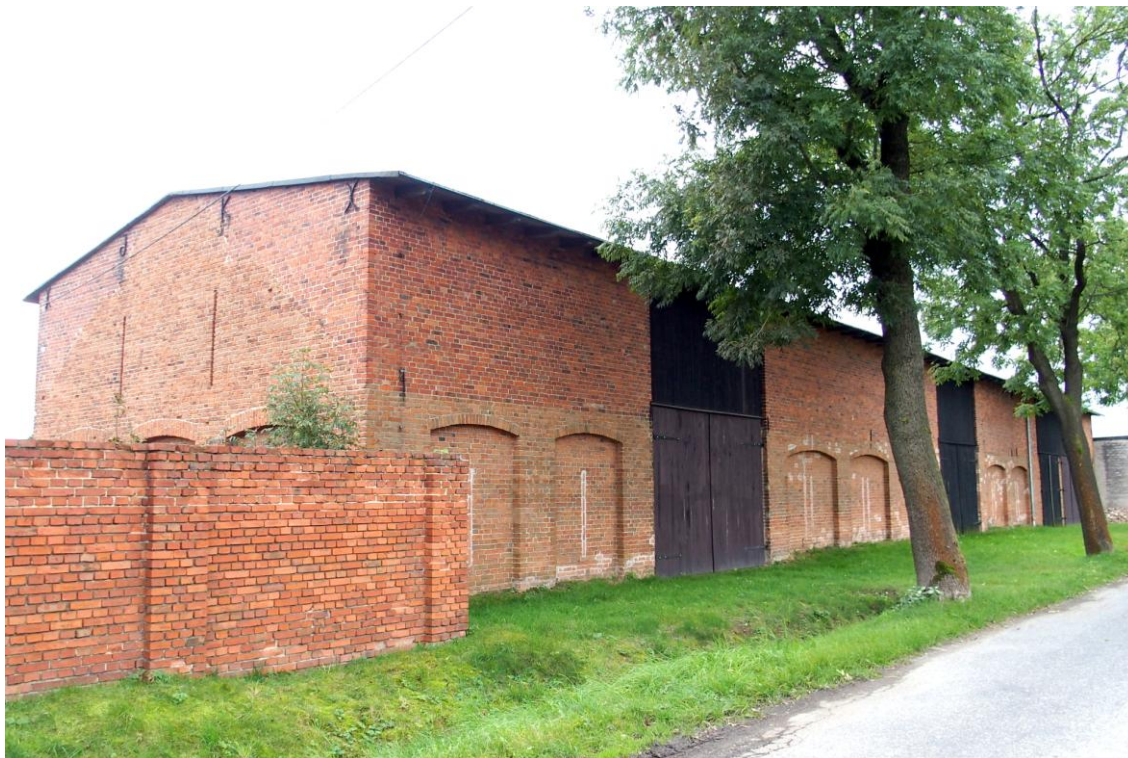
Widok budynku od północnego - wschodu
