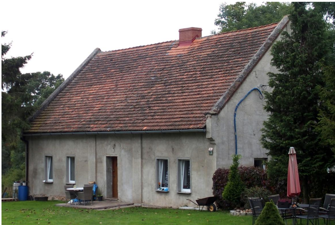
Widok budynku od północnego - wschodu
