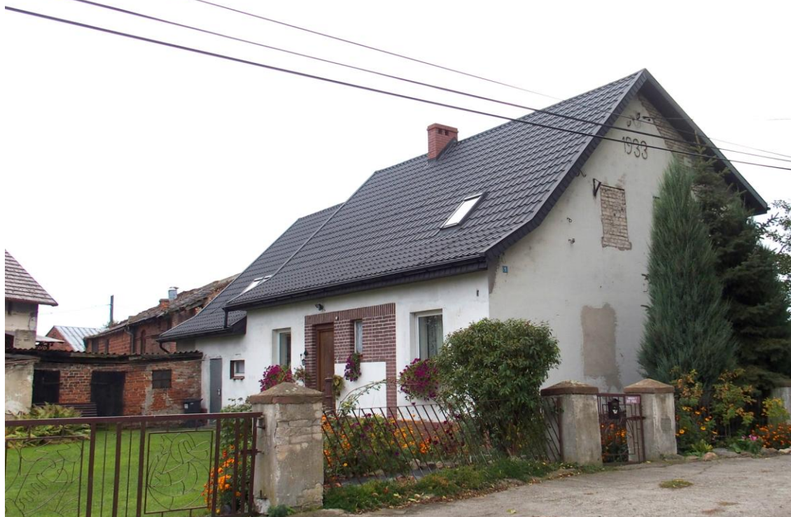
Widok budynku od północnego - wschodu
