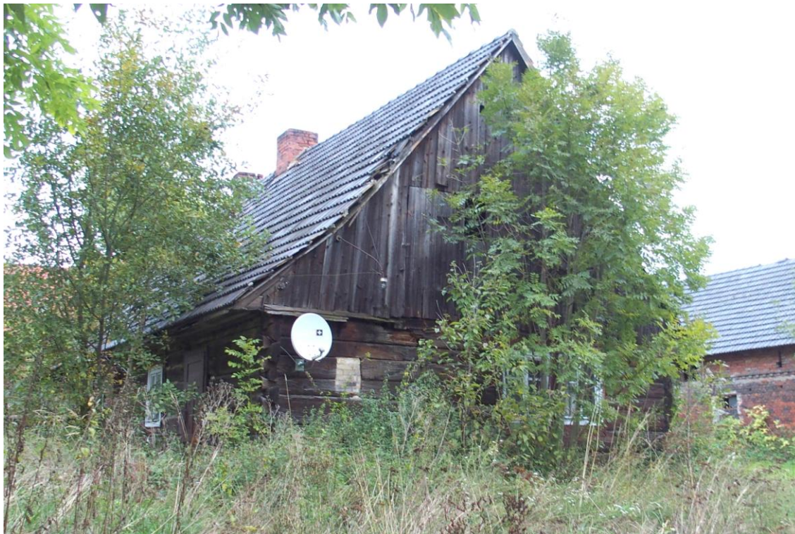
Widok budynku od południowego - zachodu
