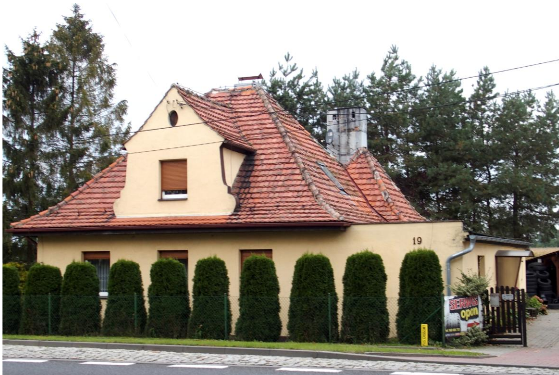
Widok budynku od wschodu
