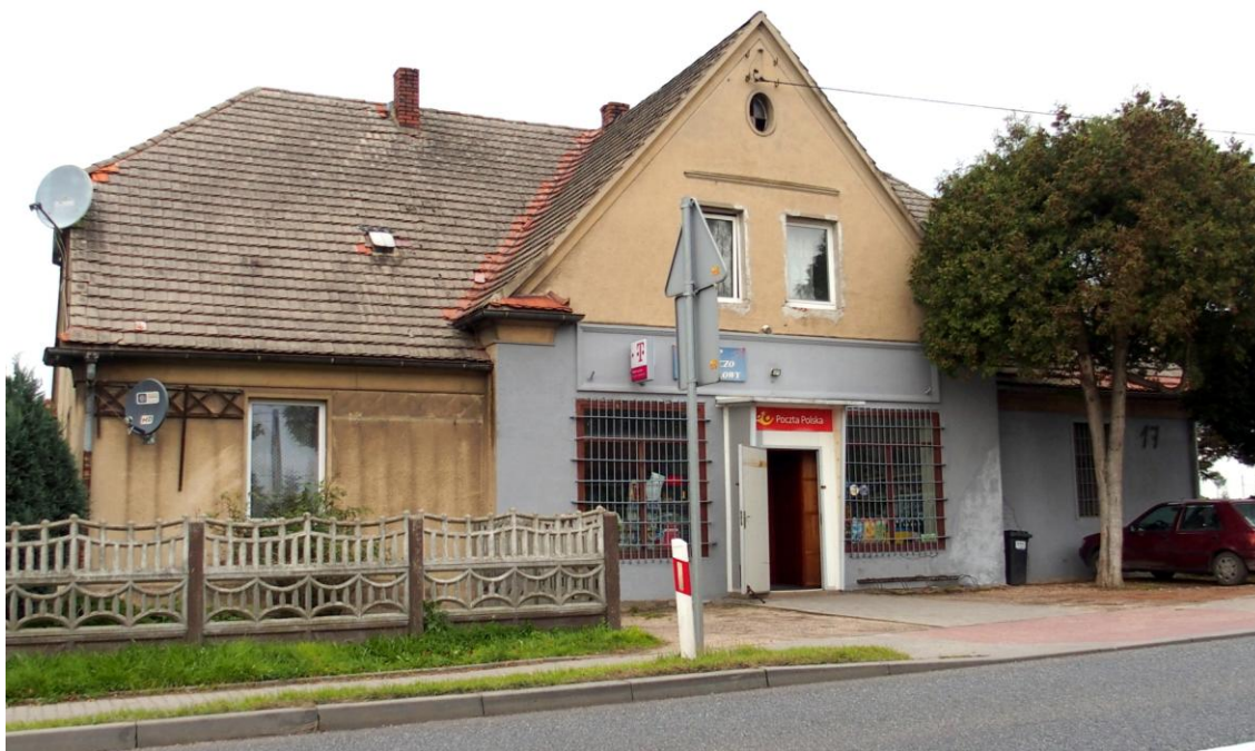
Widok budynku od południowego - wschodu
