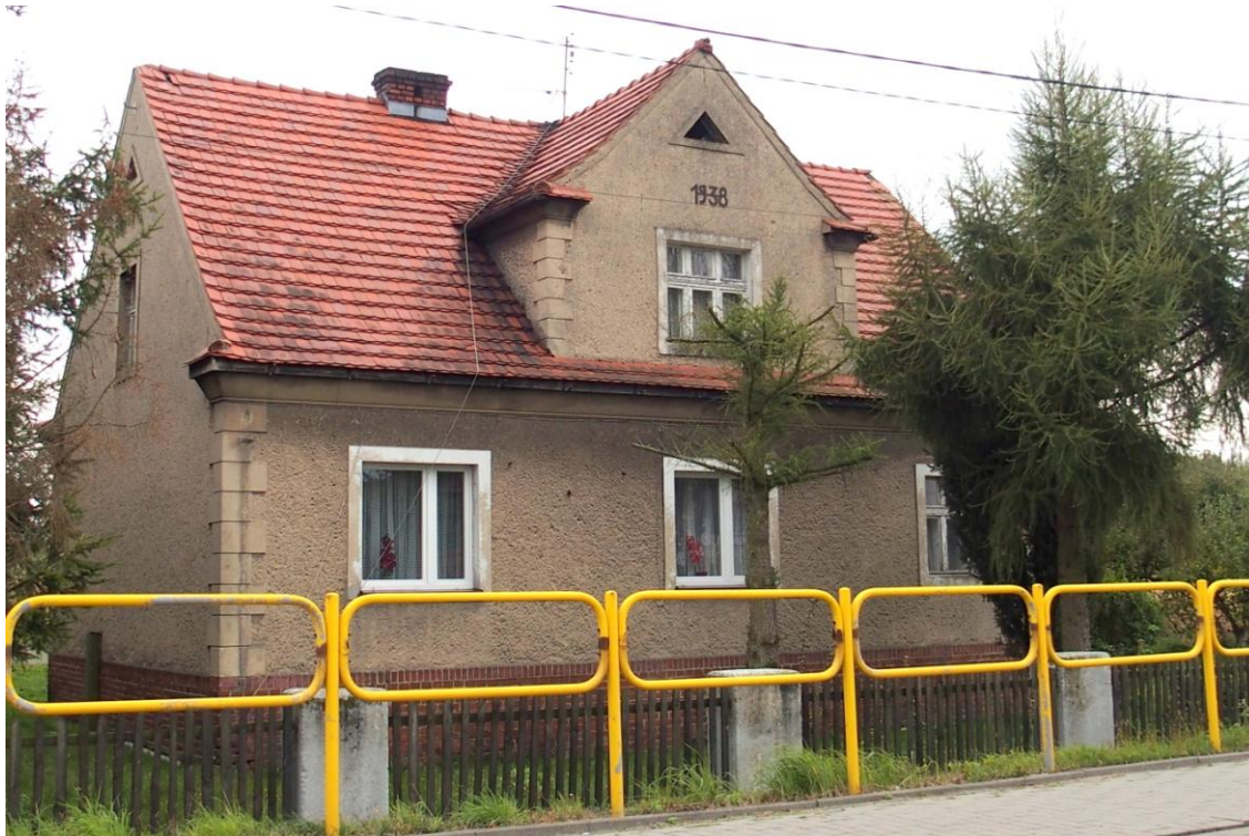
Widok budynku od północy
