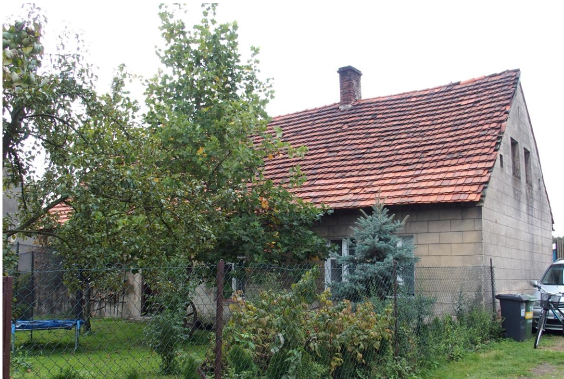
Widok budynku od północnego - wschodu
