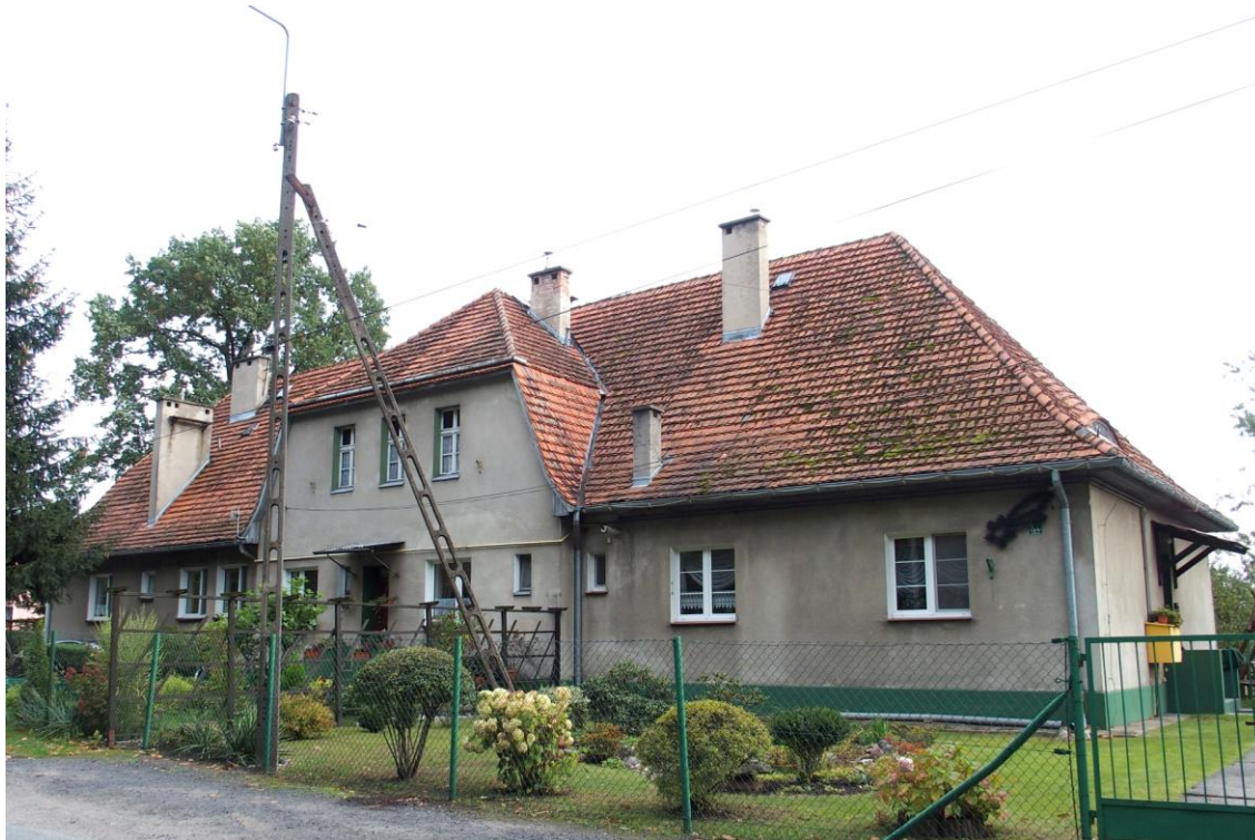
Widok budynku od północnego - zachodu
