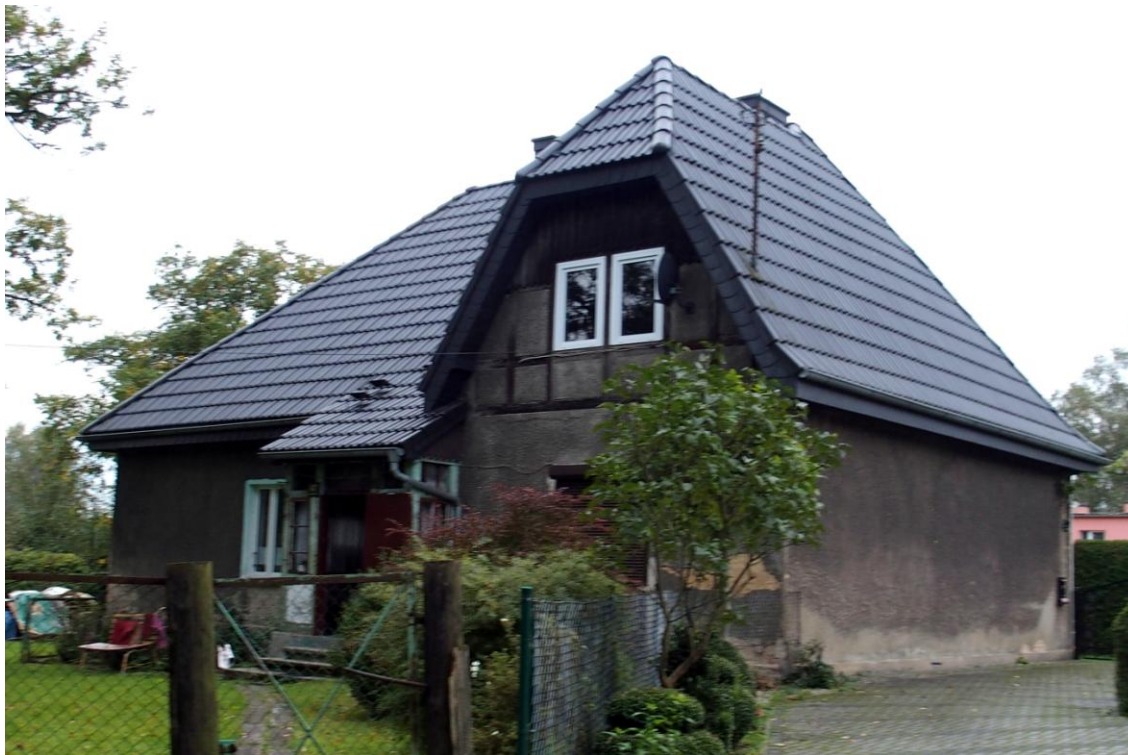
Widok budynku od wschodu
