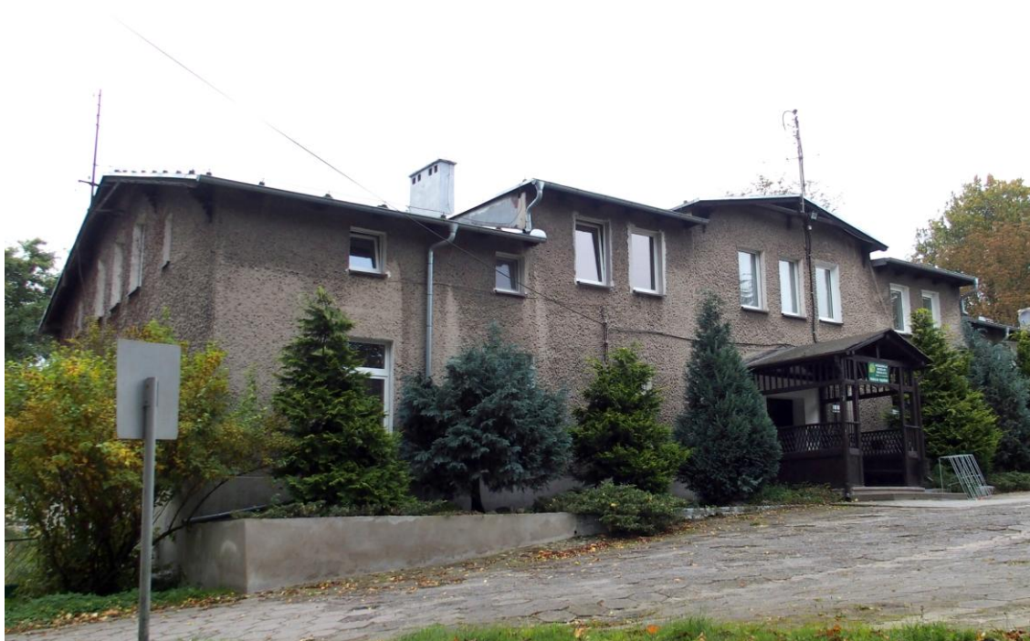
Widok budynku od południowego - wschodu
